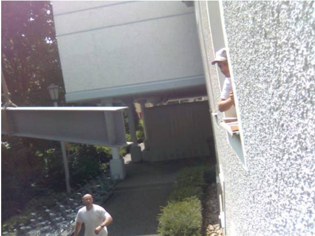
Unterzugträger als statischer Ausgleich für die entfernte Wand
