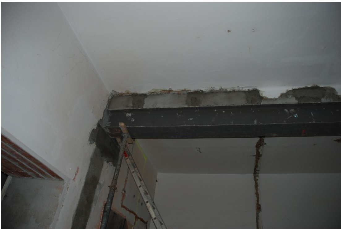
Unterzugträger als statischer Ausgleich für die entfernte Wand
